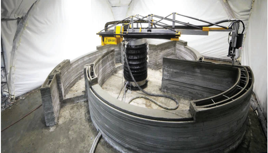
Şekil 2. 3d Yazıcı Beton Makinesi 4
